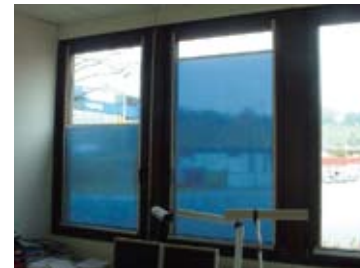
Folienrollos, mit einem Rahmen von innen an die Fenster gesetzt (Modell Alpinastar, www.blendfrei.com )
